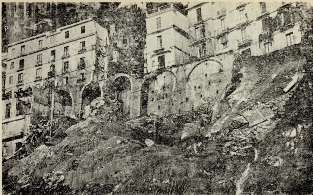
Via De Marinis vista dalla spiaggia: si nota il palazzo Mazzariello abbattuto, e il ponte della strada nazionale (Foto Sport - Salerno)
