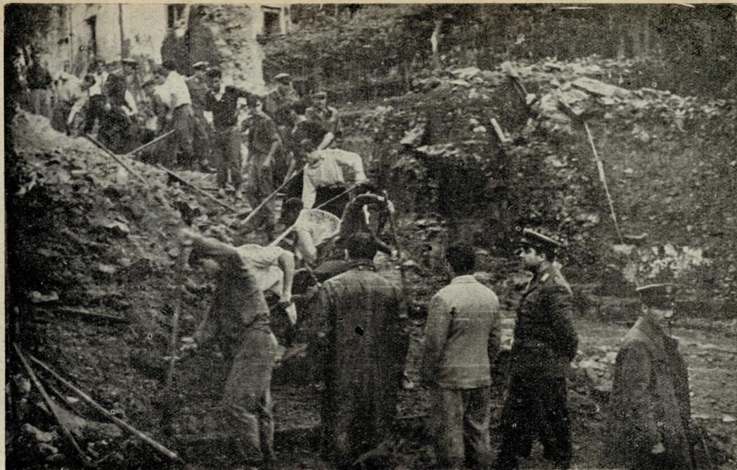
A Canalone i volontari spalatori aprono un varco per aprire la strada.
