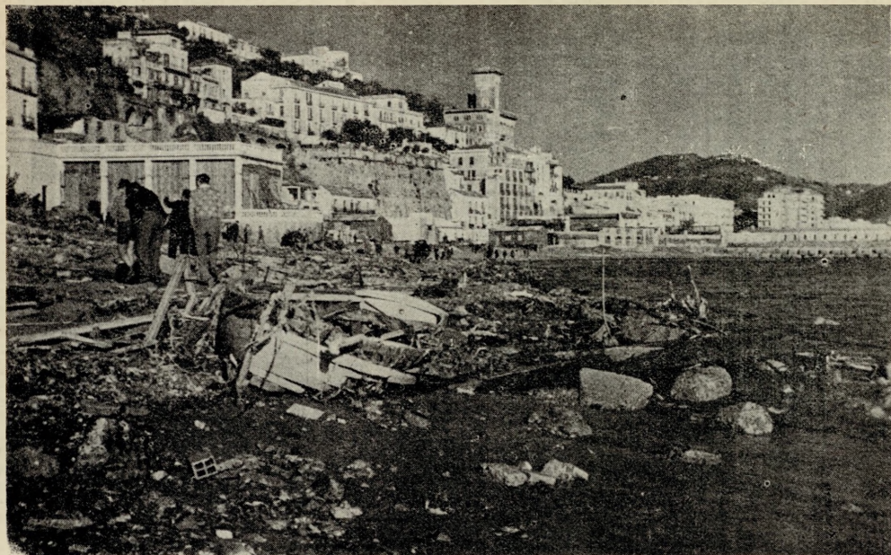
La spiaggia dell'acqua del fico invasa dai detriti della strada sovrastante.
