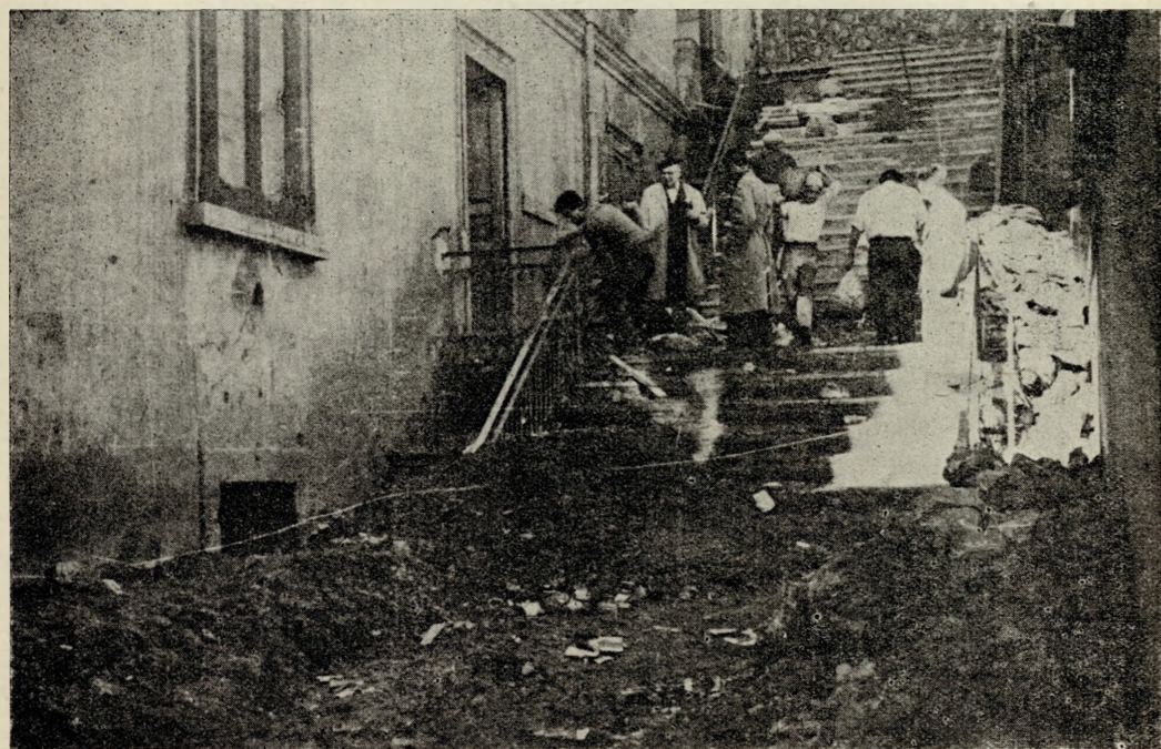
La costruente rampa che porta a via Monti: l'avvocato F. Alario ex sindaco di Salerno, guarda lo sgombero del terriccio davanti la porta della sua abitazione.
