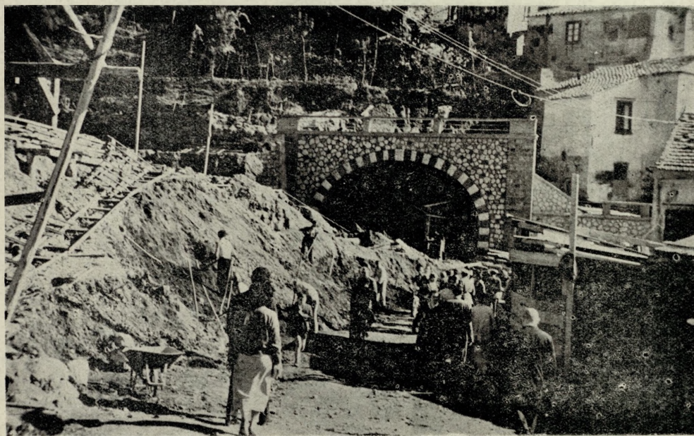
La galleria dell'autostrada a Canalone. (Foto Vito Alfinito - Fratte di Salerno)
